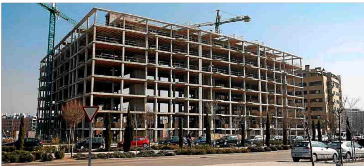
Edificio de viviendas en construcción en un barrio del norte de la capital. / DIEGO SINOVA
