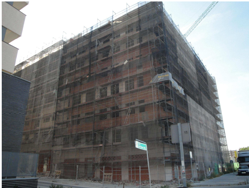
VISTA FACHADA EXTERIOR ESQUINA PORTAL1-2
