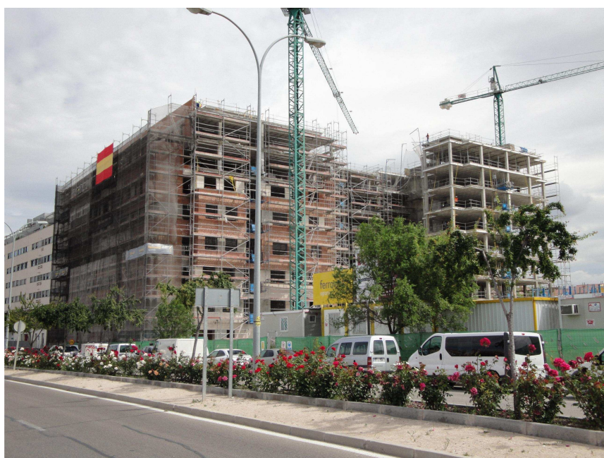
VISTA FACHADAS INTERIORES
