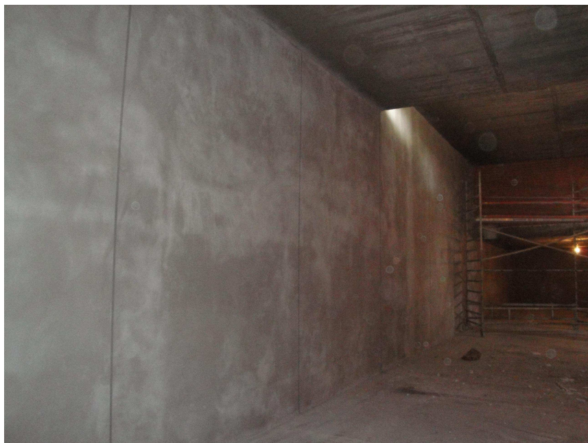
VISTA INTERIOR DEL GARAJE
